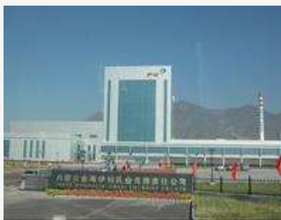
程大稳拍摄于 2007 年——伊利总部大楼
