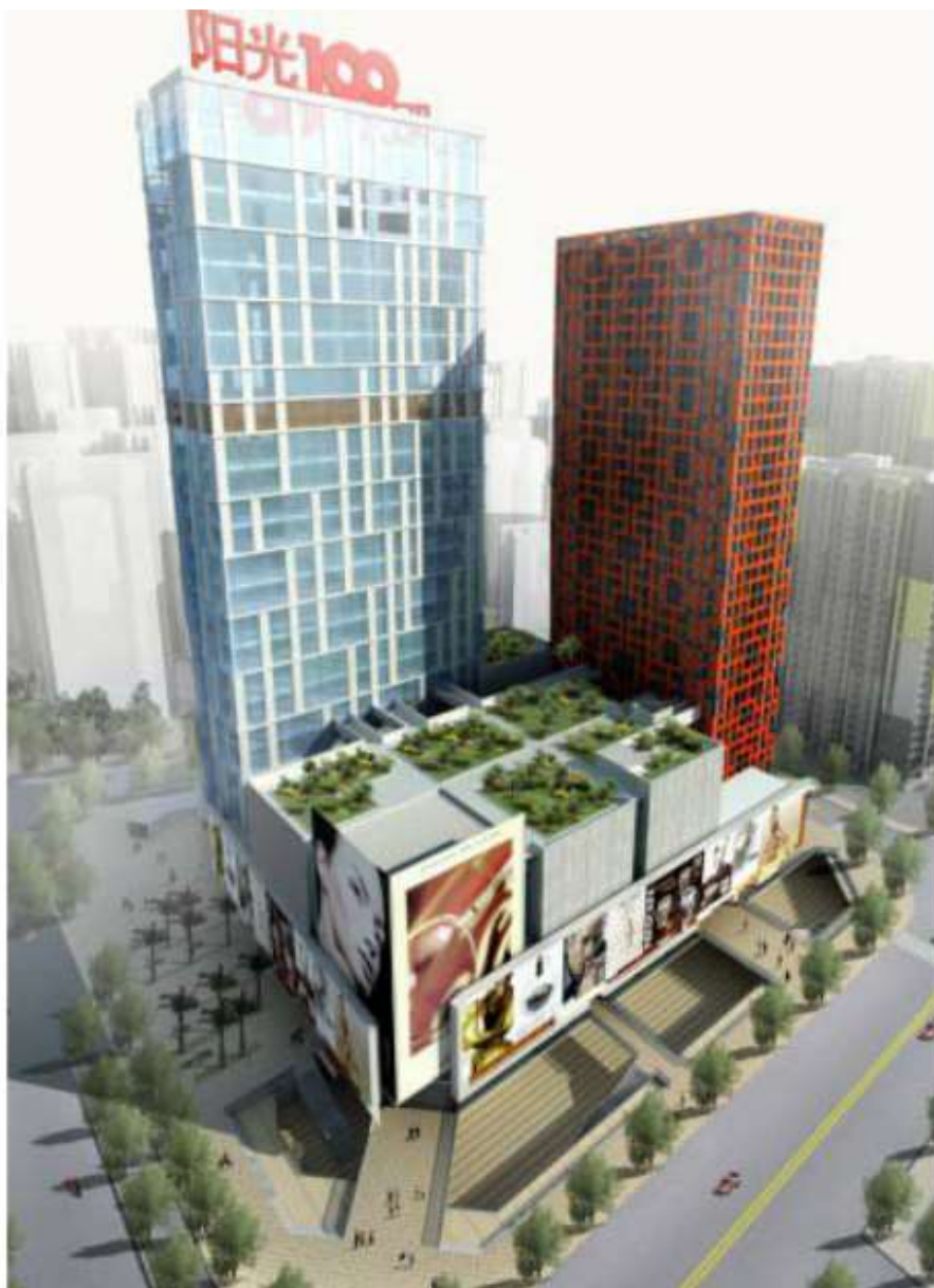
C1 整体立面效果（左边高楼为 25#办公公寓，矮的是 26#商业，27#红色建筑是精装住宅）
